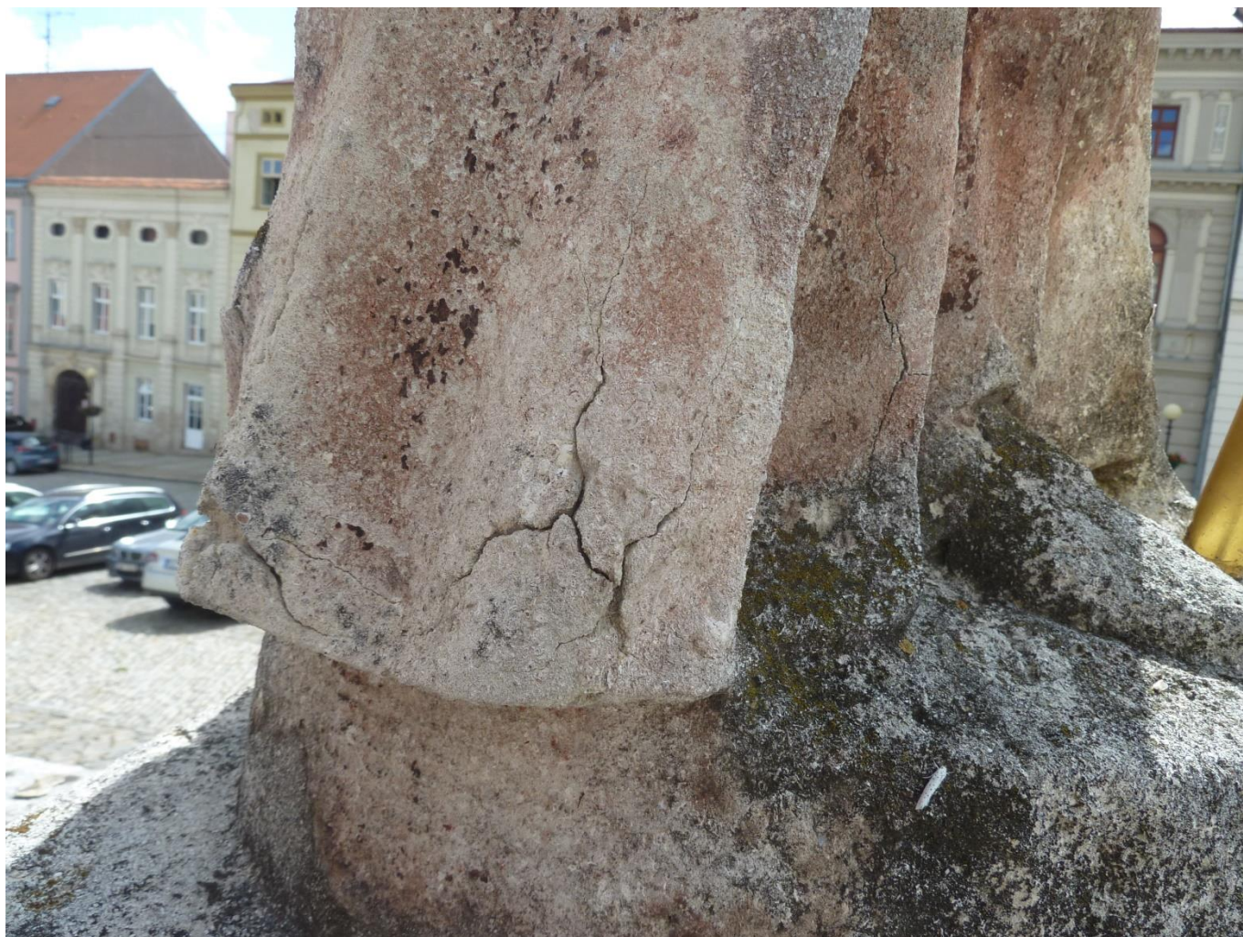
Socha svatého Mikuláše. Praskliny ve spodní části pláště.
