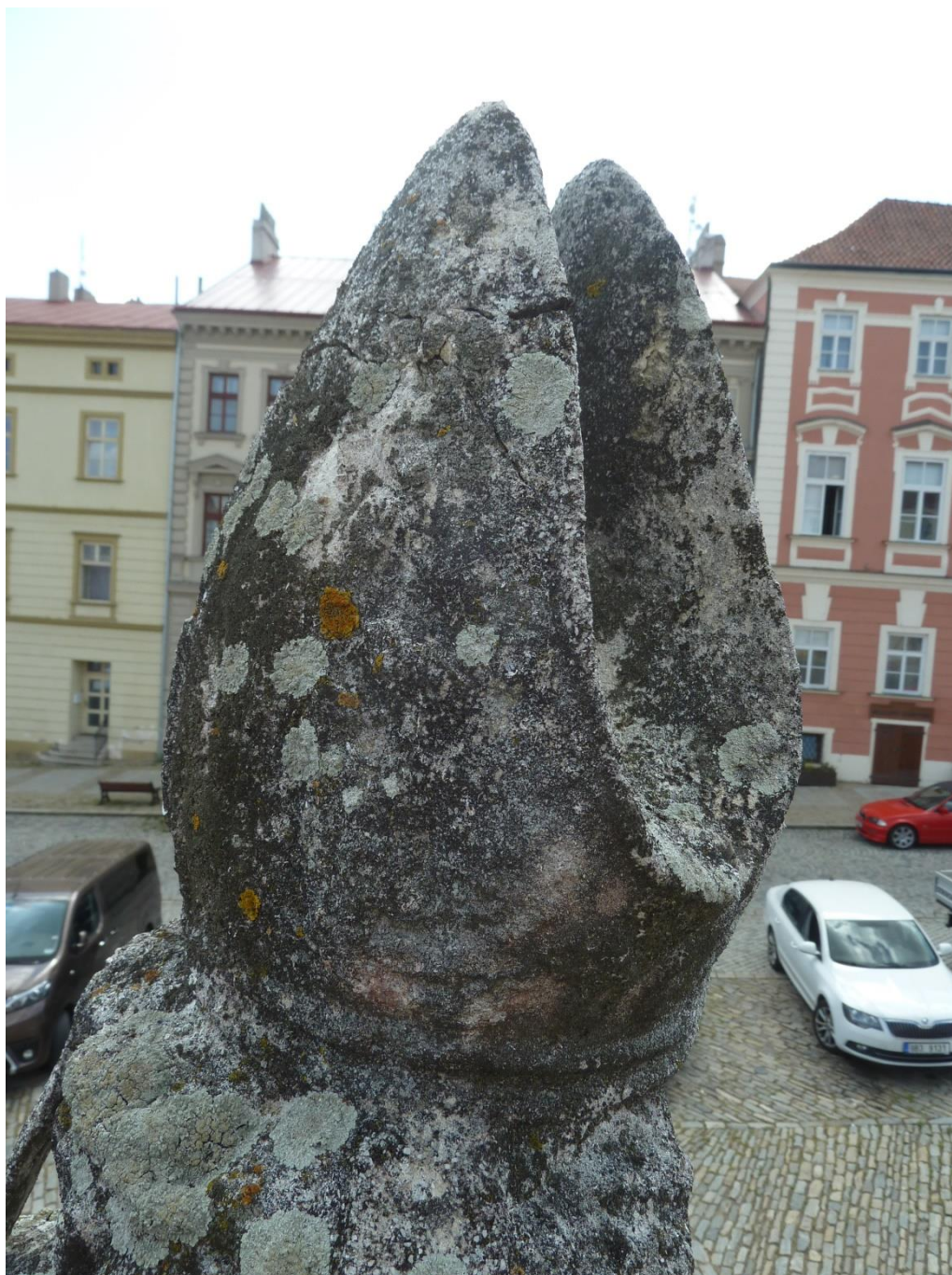
Socha svatého Mikuláše. Praskliny v horní části mitry.
