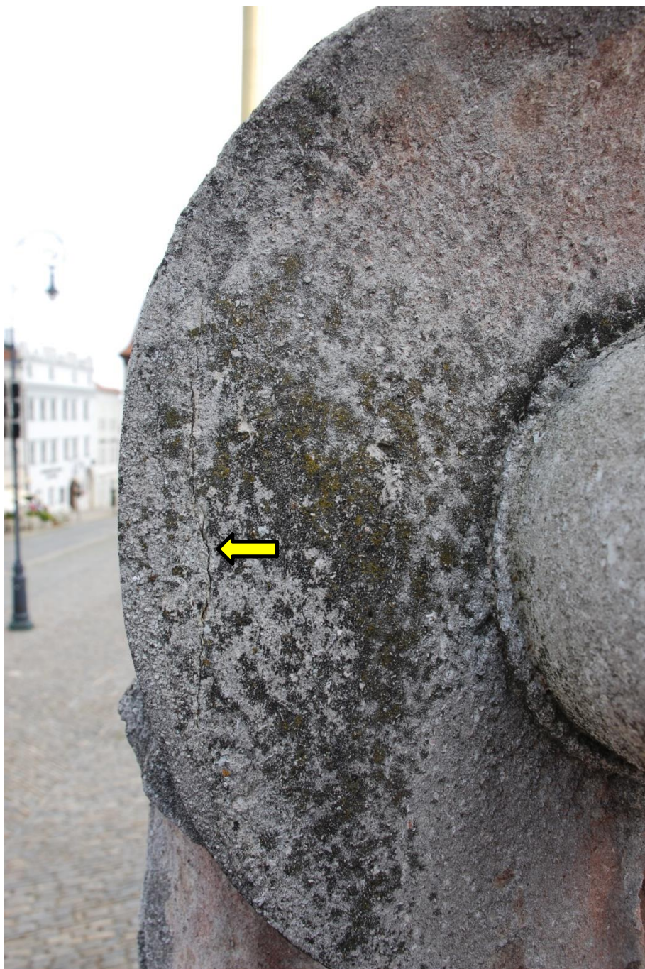
Socha svatého Rocha. Vertikální prasklina v klobouku.
